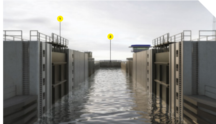
Keersluis Den Oever (rijrichting: vanaf de Waddenzee richting het IJsselmeer)
