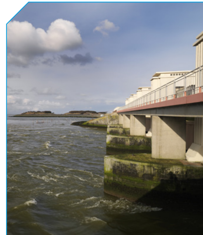
Afsluitdijk bij Den Oever, Stevinsluizen
